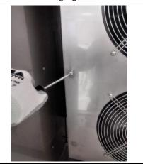
3. Die Schrauben der Haltebügel des Verdampfers lösen.
