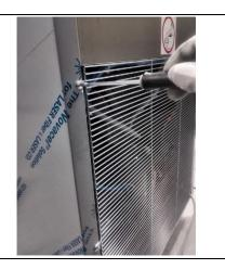
2. Das Gas mit dem entsprechenden Rekuperator zur Lagerung des Kältemittels von der Anlage entfernen.
