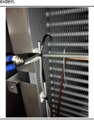
6. Das Kabel des Fühlers abschneiden.
