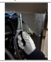
10. Den Isolierschaum entfernen, um die Kabel freizulegen.
