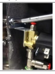
**4.** Den Bügel von der Ventileinheit entfernen.
