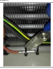
**6.** Das Kabel des Fühlers abschneiden.
