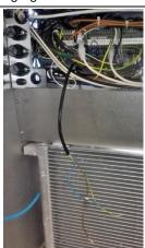
13. Das Kabel des Lüfters vom Klemmenbrett abtrennen [siehe elektrischen Schaltplan Abschnitt 10].
