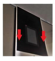
**12.** Die Dichtung wieder am oberen Profil der Bedientafel positionieren.
