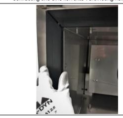
**23.** Alle Verbindungsecken der Deckel mit Silicon für Bleche versiegeln.
