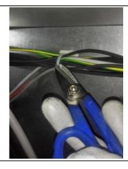
**12.** Das Fühlerkabel nach unten ziehen und darauf achten, es so weit wie möglich senkrecht zum Kammerboden auszurichten.
