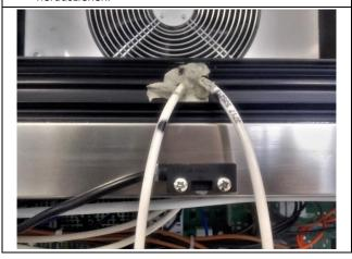
8. Den Deckel der elektrischen Verteilerdose entfernen.
