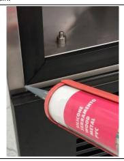
**24.** Das Silikon mit einem Stück Karton auftragen und die Rückstände mit Alkohol reinigen.
