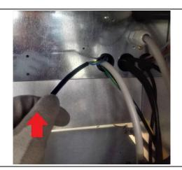
**12.** Alle Schellen am Schaltschrank beseitigen, um das Entfernen des Netzkabels des auszutauschenden Lüfters und den Durchgang des neuen Lüfters zu erleichtern.
