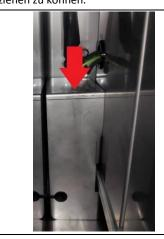
5. Die Schellen zur Befestigung des Fühlerkabels abschneiden.
