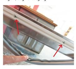
Öffnen Sie den Zug und ziehen die Dichtung am oberen Rand ab. Unter bzw. hinter der Dichtung befinden sich die Schrauben, die den Bügel- / Segmentbogengriff fixieren.
